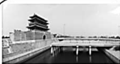
图a 2004年正在修建的中的永定门城楼及护城河倒影
